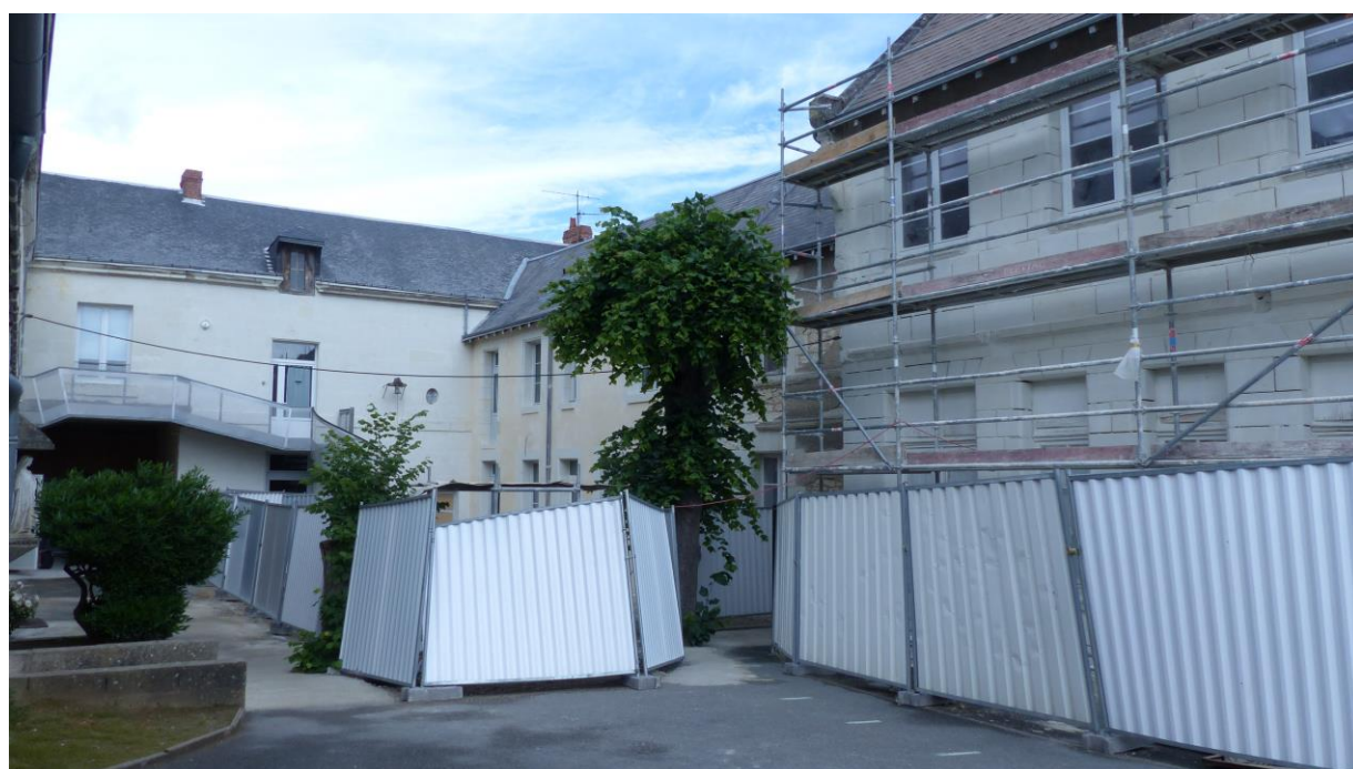
Le chantier avance ! L'école commence à avoir fière allure !
