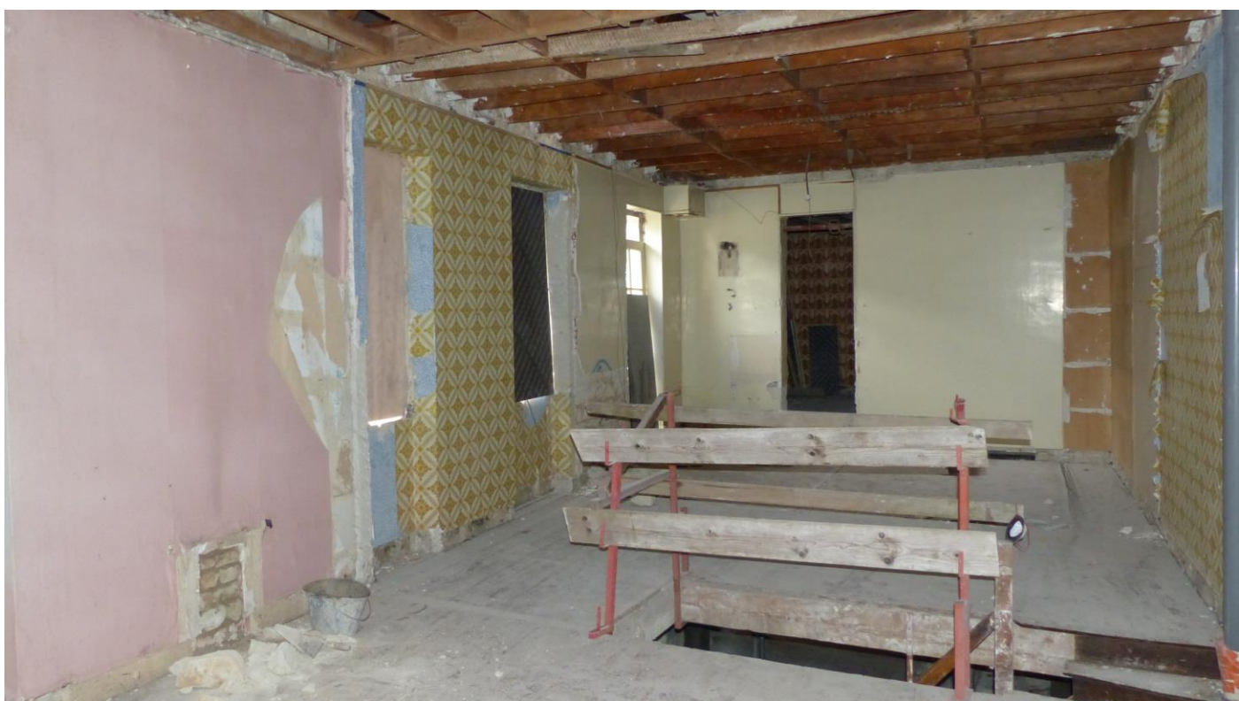
Nouvelle salle au 1 er étage, ancien grenier, l'escalier au centre va être enlevé.
