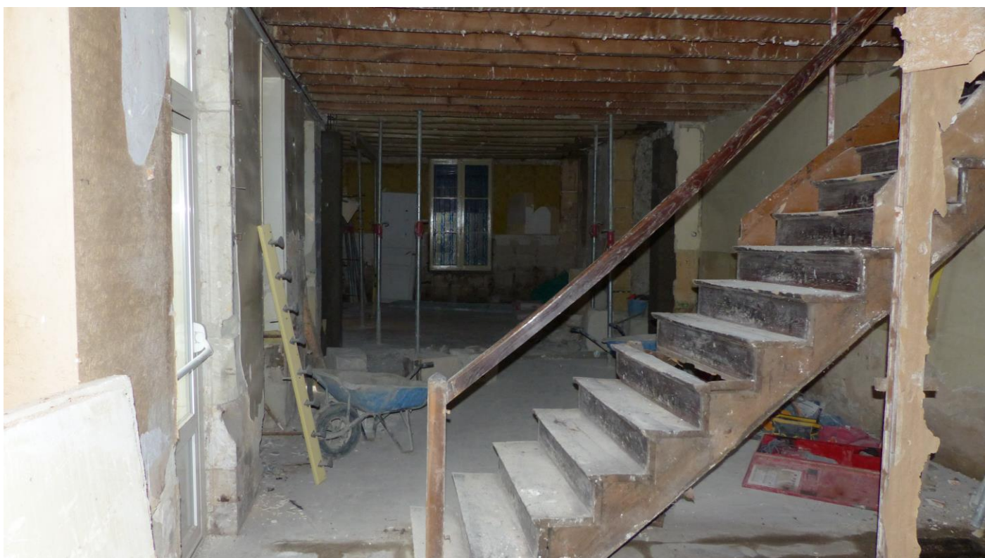
Future salle de restauration vue de l'autre côté, ancien débarras. L'escalier va tomber.
